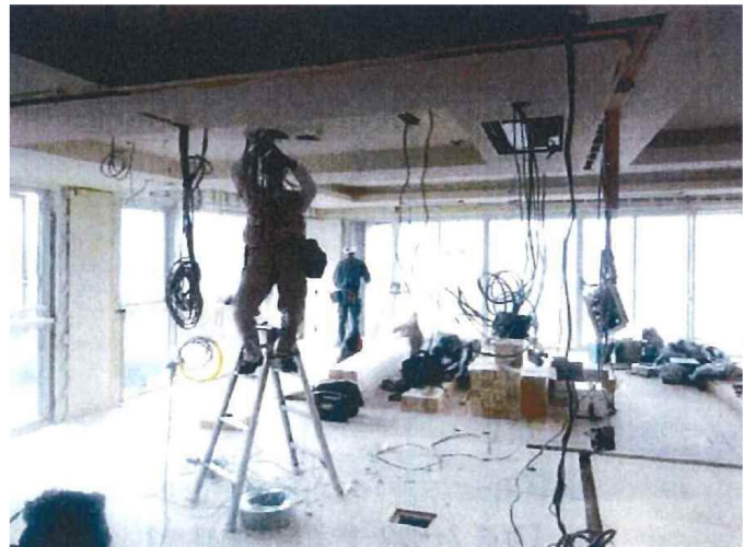
「電気工の照明器具設置作業」
